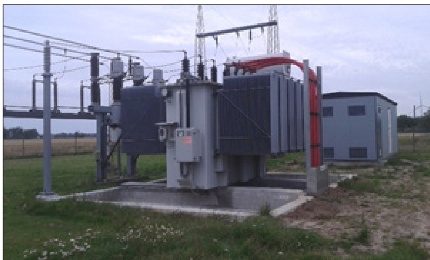
Figur 4. Eksempel på udformning af 60/10 kV transformer.
