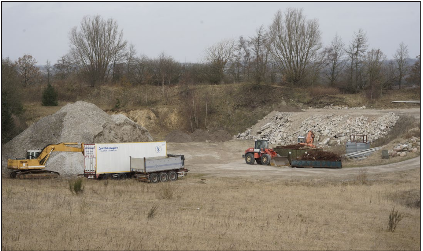
Matr. 4d - 2021: Grusgraven bruges ikke længere til råstofindvinding, men som lager og deponi af byggeaffald.
